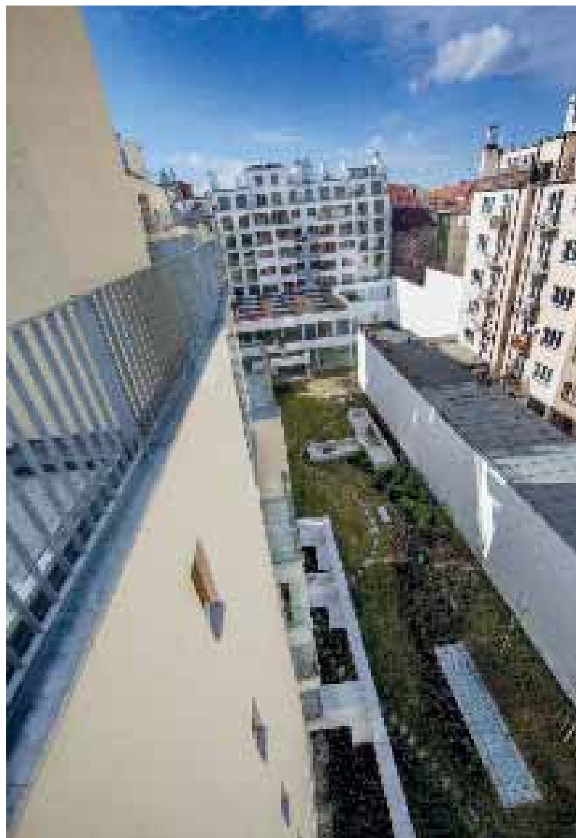
Parkové úpravy s fontánou/Landscaping with fountain
